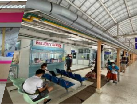
Logistic:ท่อลม
