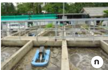
รูปที่ 3 ตัวอย่างระบบบำบัดน้ำเสียแอสแบบคูวนเวียน (Oxidation Ditch : OD) ของโรงพยาบาล
