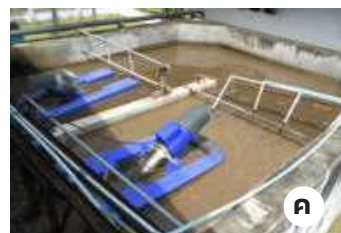
รูปที่ 3 ตัวอย่างระบบบำบัดน้ำเสียแอสแบบคูวนเวียน (Oxidation Ditch : OD) ของโรงพยาบาล
