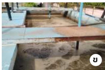
รูปที่ 1 ตัวอย่างระบบบำบัดน้ำเสียแอสแบบผสมสมบูรณ์ (Activated Sludge : AS) ของโรงพยาบาล
