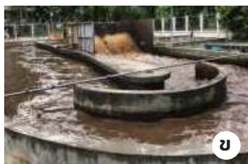
รูปที่ 3 ตัวอย่างระบบบำบัดน้ำเสียแอสแบบคูวนเวียน (Oxidation Ditch : OD) ของโรงพยาบาล
