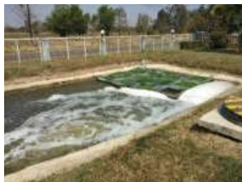
รูปที่ 2 ตัวอย่างระบบบำบัดน้ำเสียแอสแบบสระเติมอากาศ (Aerated Lagoon : AL) ของโรงพยาบาล
