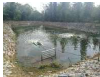
รูปที่ 2 ตัวอย่างระบบบำบัดน้ำเสียแอสแบบสระเติมอากาศ (Aerated Lagoon : AL) ของโรงพยาบาล
