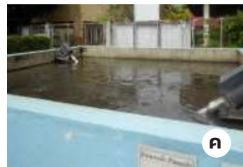
รูปที่ 1 ตัวอย่างระบบบำบัดน้ำเสียแอสแบบผสมสมบูรณ์ (Activated Sludge : AS) ของโรงพยาบาล
