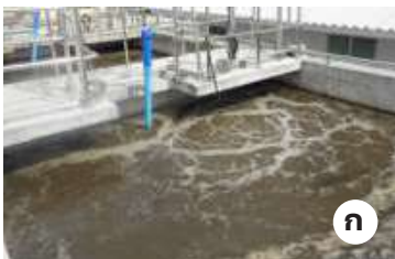
รูปที่ 1 ตัวอย่างระบบบำบัดน้ำเสียแอสแบบผสมสมบูรณ์ (Activated Sludge : AS) ของโรงพยาบาล
