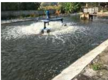
รูปที่ 2 ตัวอย่างระบบบำบัดน้ำเสียแอสแบบสระเติมอากาศ (Aerated Lagoon : AL) ของโรงพยาบาล
